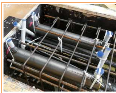
Precast wall production
