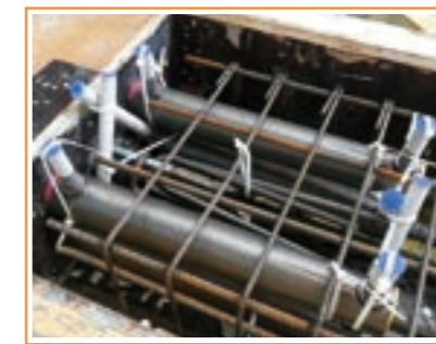
Precast wall production
